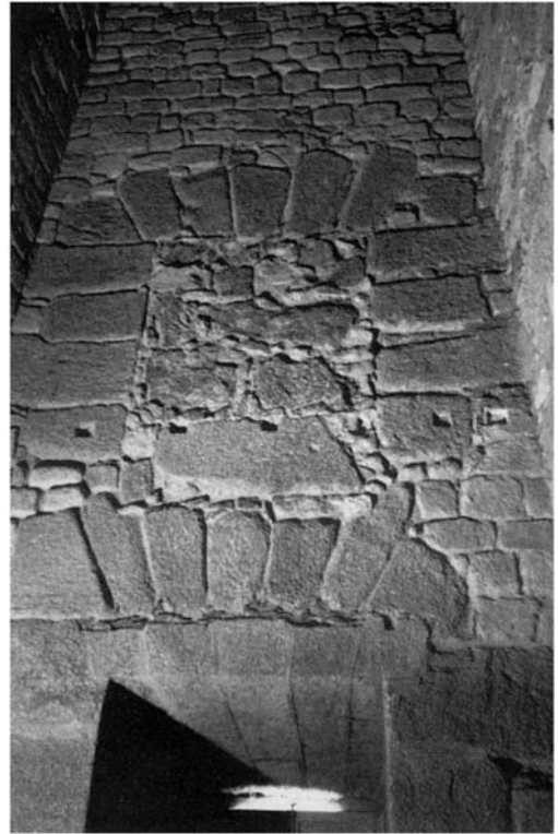
Fig. 29 – Aspecto interno do aparelho construtivo do farol da Corunha
